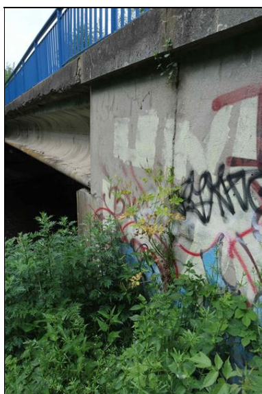
Pohled na levé křídlo opěry 01 - mírně otevřená dilatační spára mezi dříkem opěry a křídlem. Ve spáře stopy po menším zatékání.
