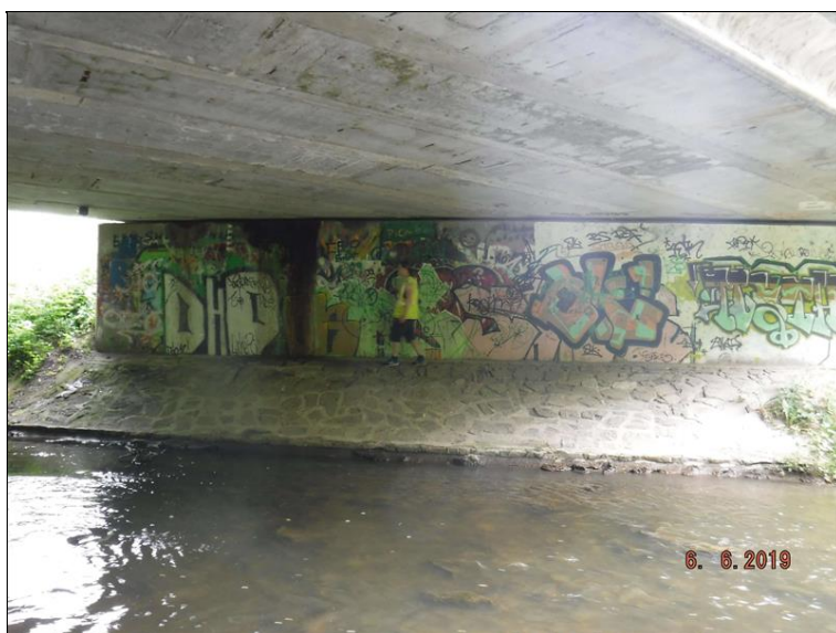
Pohled na levé křídlo opěry 01 - mírně otevřená dilatační spára mezi dříkem opěry a křídlem. Ve spáře stopy po menším zatékání.
